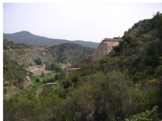
Figure 4 Le coté droit du barrage
