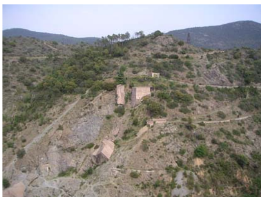
Figure 3 Le coté gauche du barrage
