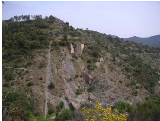
Figure 5 Le dièdre de rupture et le plan de foliation (rive gauche)
