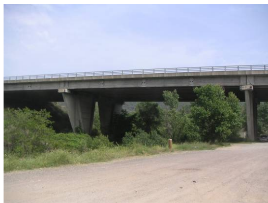
Figure 1 : Le pont de l'autoroute
