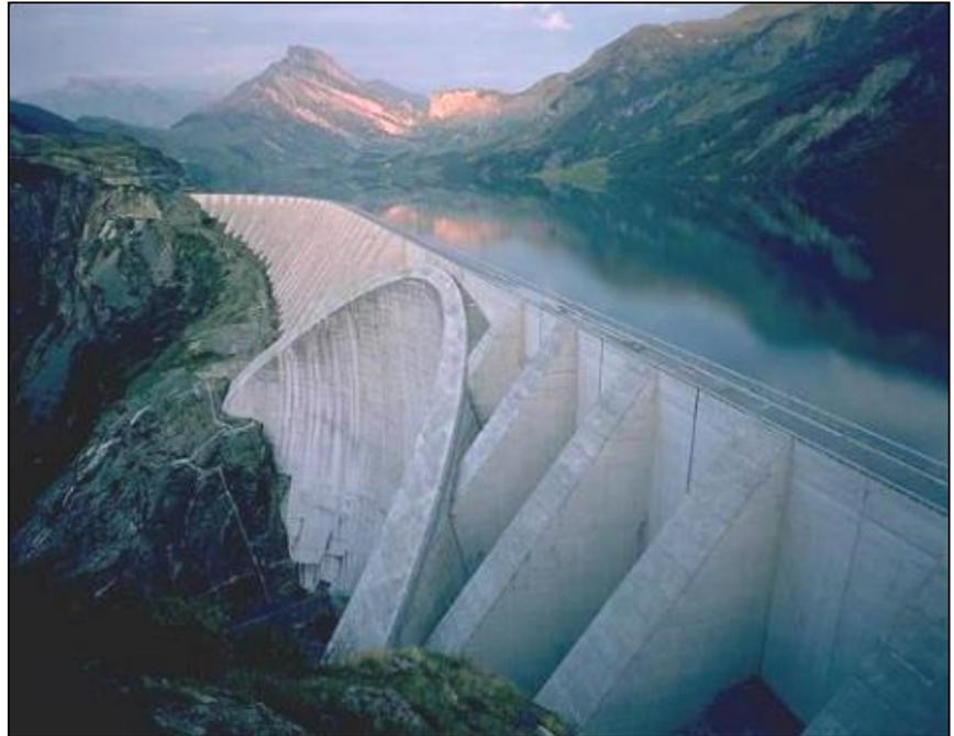
*Barrage de Yaté (Nouvelle-Calédonie h=60m) barrage voûte, poids, contreforts et terre*
