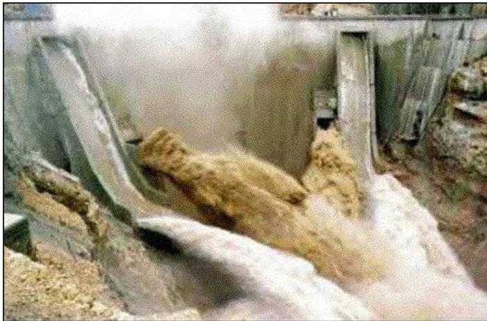
*2 évacuateurs à saut à ski et 2 évacuateurs en charge lors de la crue des 500 ans au barrage de Jiroft (IRAN h=134m)*
