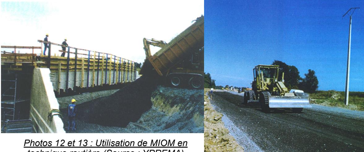
*Photos 12 et 13 : Utilisation de MIOM en technique routière (Source : YPREMA)*
