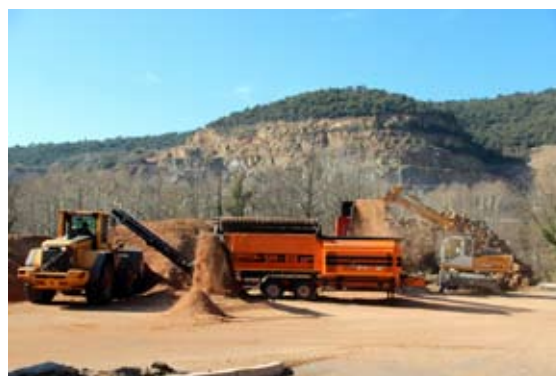
Plateforme bois énergie de La Môle
