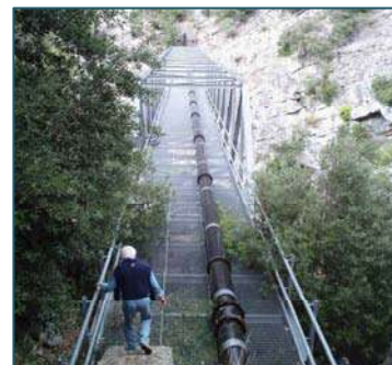
Canal Belletrud sur le pont suspendu au dessus des Gorges de la Siagne
