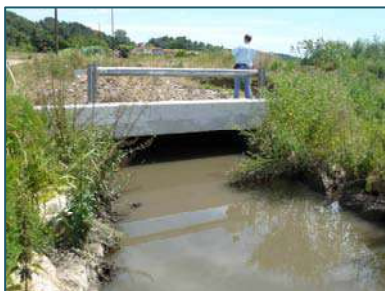
Ouvrage hydraulique (OH4) sur le Béal
