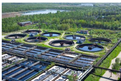
Figure 5 : Bassins de traitement (source : Rackam)
