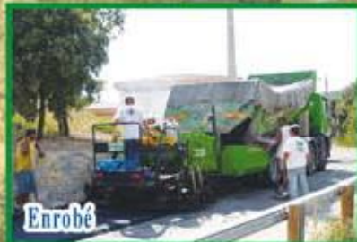
Terrassement de Villas
