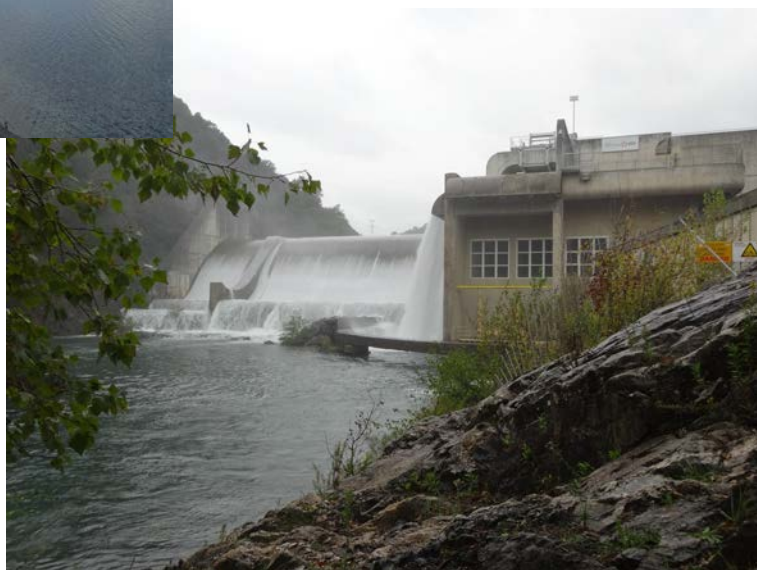
Ci-contre Le barrage de Tignet-Tanneron (CESAME 2016)
