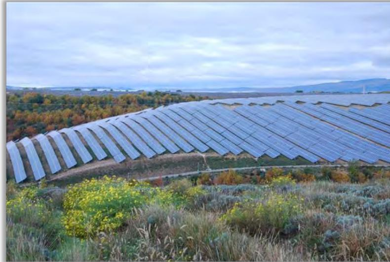
La centrale a été conçue pour s'adapter au mieux à la topographie du terrain et limiter l'impact sur les sols. En effet il a été retenu la technologie de structure sur pieux battus qui permet une utilisation du sol minimale et la meilleure réversibilité.
